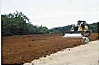
道路の路床盛土に再利用
