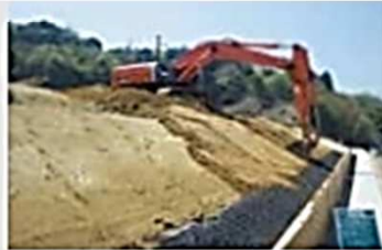
道路の路体盛土に再利用
