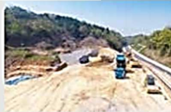
大規模造成工事
